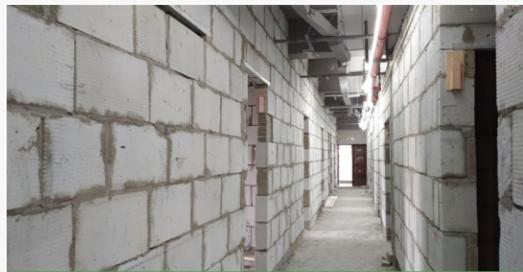
使用环保加气块砖砌筑的墙面
